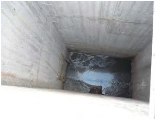
Punto de muestreo de lodo primario (Sedimentadores Primarios). Planta de Tratamiento del Cerro de la Estrella. Ciudad de México.
