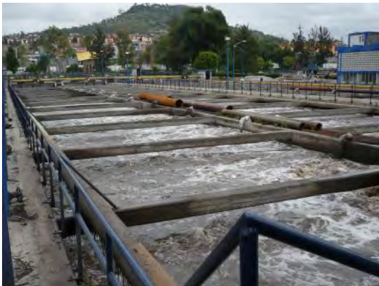
Punto de muestreo de lodo secundario (tanques de aireación de lodos activados). Planta de Tratamiento del Cerro de la Estrella. Ciudad de México.
