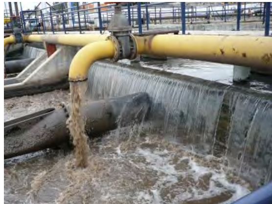
Punto de muestreo de lodo secundario (tanques de aireación de lodos activados). Planta de Tratamiento del Cerro de la Estrella. Ciudad de México.
