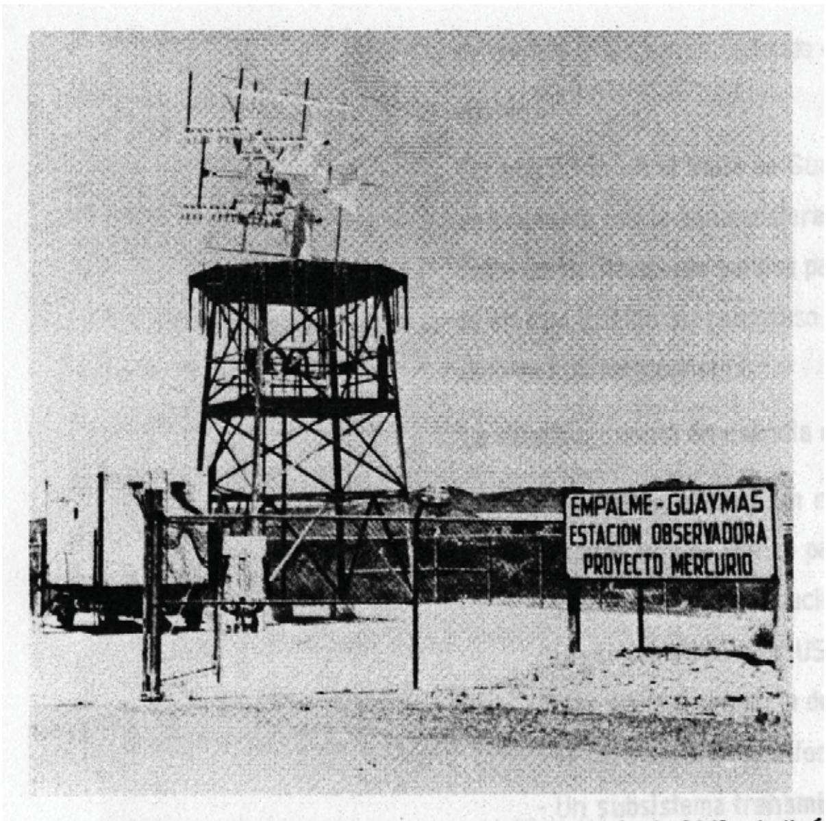
Fig. 1.8 Estación de rastreo Empalme-Guaymas
