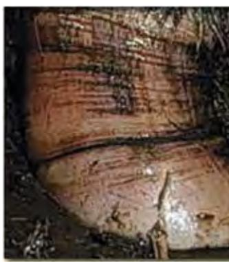
Figura 21. Fisura horizontal
