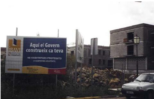
Fig.22. Comunidad de viviendas en Artá, donde se instaló el sistema de reutilización. Fuente: Ecoagua, Tecnología Española.
