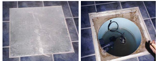
Fig.19. Depósito-arqueta en vivienda unifamiliar y su interior (derecha) Fuente: Ecoagua, tecnología Española.
