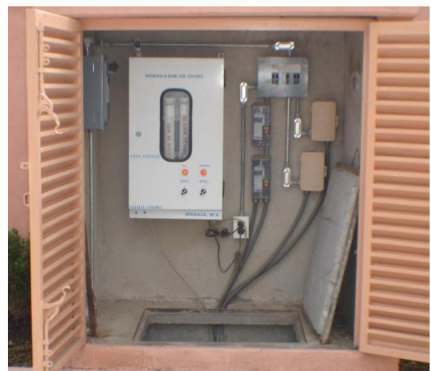
Fig.37. Ozonador Fuente. ©Sandra Pliego Hdz.
