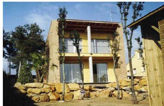
Fig.20. Vivienda unifamiliar con sistema de reutilización de aguas grises. Fuente: Ecoagua, Tecnología Española.
