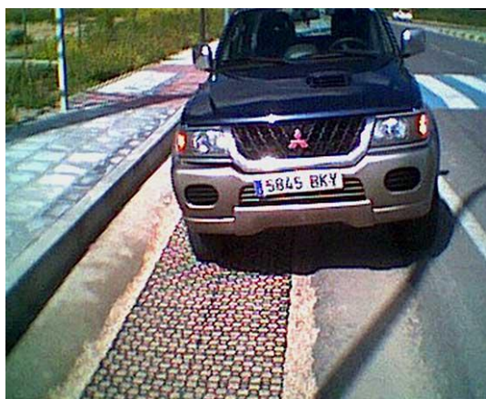
Fig.05. Colectores transitables.
