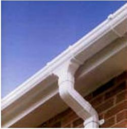
Fig.44. Canaletas para la recolección del Agua Pluvial. Fuente: Guía de diseño para captación de agua de lluvia; Unidad de apoyo técnico en saneamiento básico rural.
