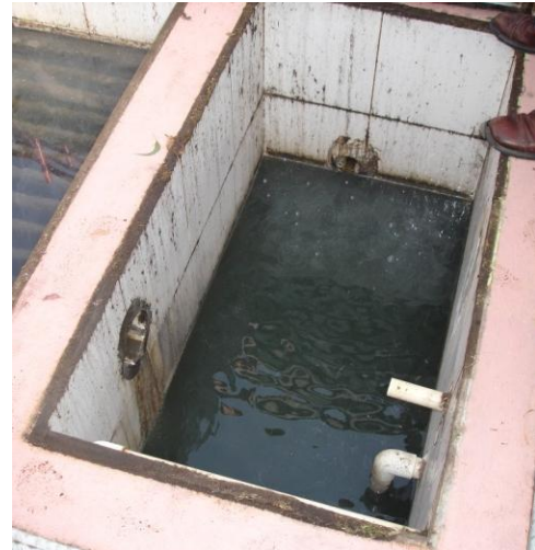
Fig.35. Cuarta fase del tratamiento del Agua Gris. Fuente. ©Sandra Pliego Hdz.
