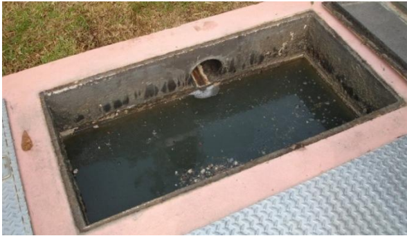
Fig.32. Primera fase del tratamiento del Agua Gris. Fuente. ©Sandra Pliego Hdz.
