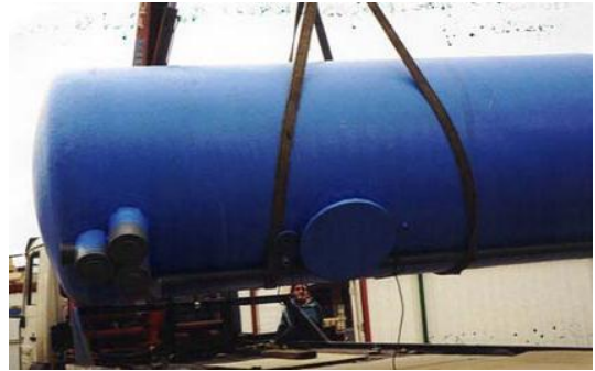
Fig.23. Instalación del depósito-depuradora entre. Fuente: Ecoagua, Tecnología Española.
