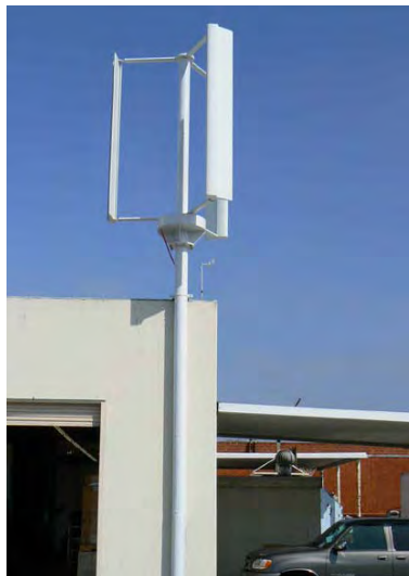
Fig. 9.1.7-1 Aerogenerador eólico para la alimentación secundaria de la planta de desalación
