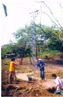
Figura 9.3.3-2 Mano de obra y maquinas simples para perforación
