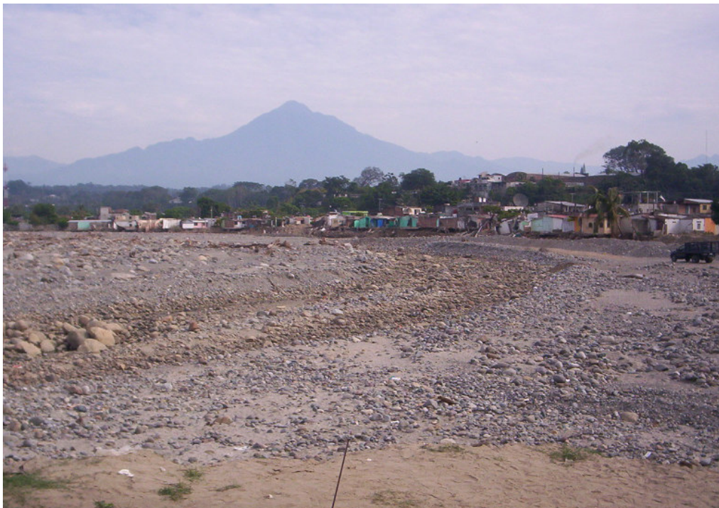
Vista de la zona devastada por el desbordamiento del Río Coatán en la Ciudad de Tapachula. Fraccionamiento Los Framboyanes. Fotografía: Pedro Santiago Escobar. Diciembre de 2005.
