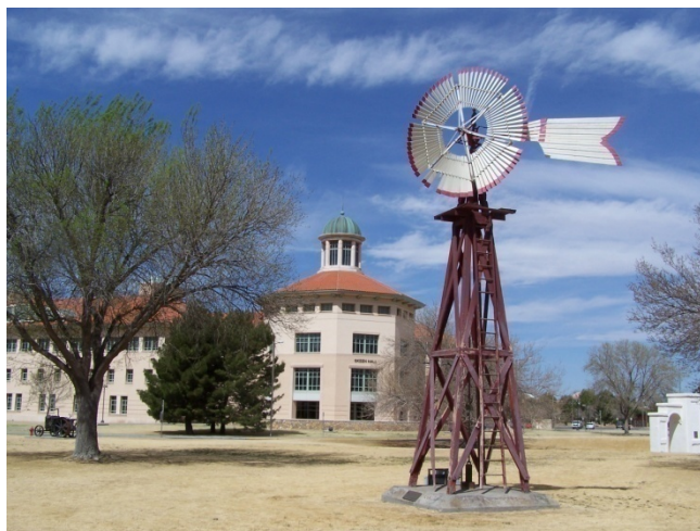
Figura B.5 Molino eólico construido de Madera; monumento histórico en la Universidad Estatal de Nuevo México, Las Cruces, NM, Estados Unidos.
