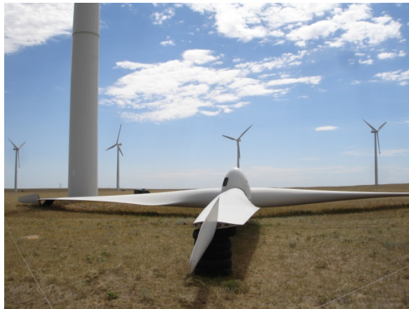
Figura 2.5 Rotor de una Turbina eólica en reparación en la central eoloeléctrica de Ponnequin, Colorado, Estados Unidos.
