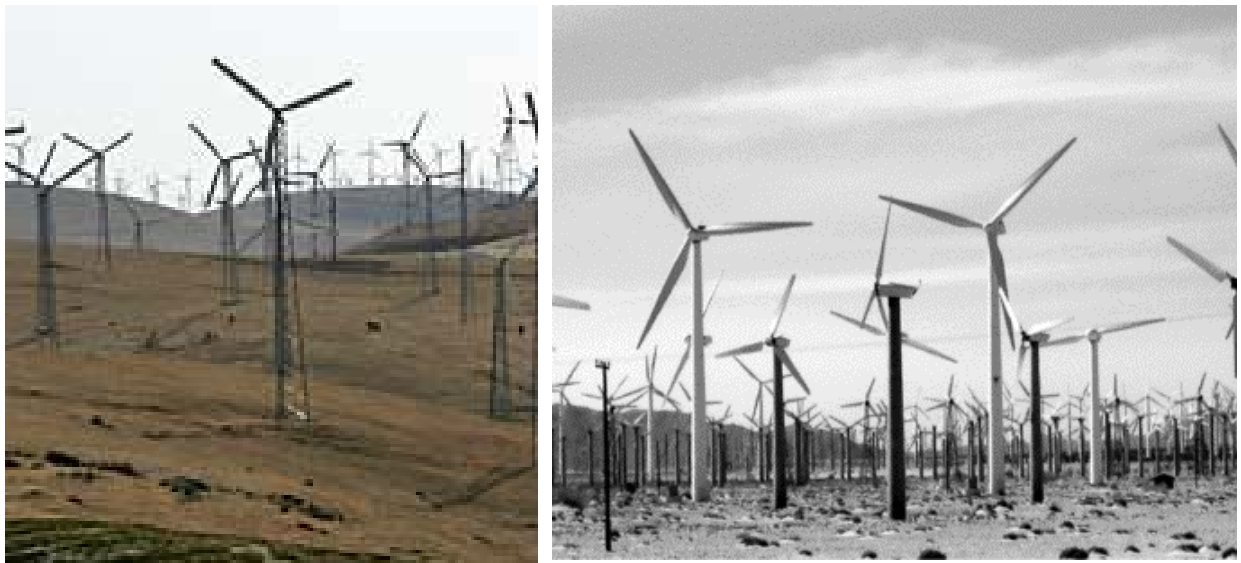
Figura 3.4 Mal Emplazamiento de turbinas eólicas en el sitio Altamont Pass, California. Se puede observar la gran concentración y diversidad de turbinas eólicas.
