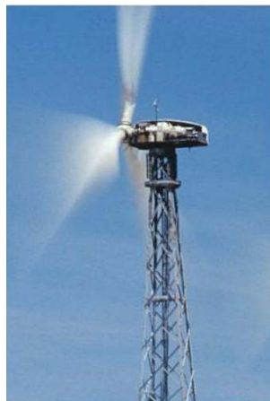
Figura 4.5 Aerogenerador sin cubierta de la nacela en San Gorgonio Pass, California. Fuente: Gipe (2008).
