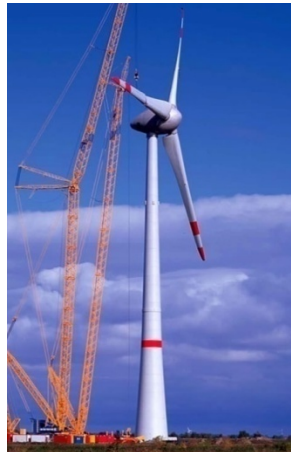
Figura 2.9 Turbina eoloeléctrica Enercon-E126 de 6 MW de capacidad 13 . Fuente: Treehugger, http://www.treehugger.com
