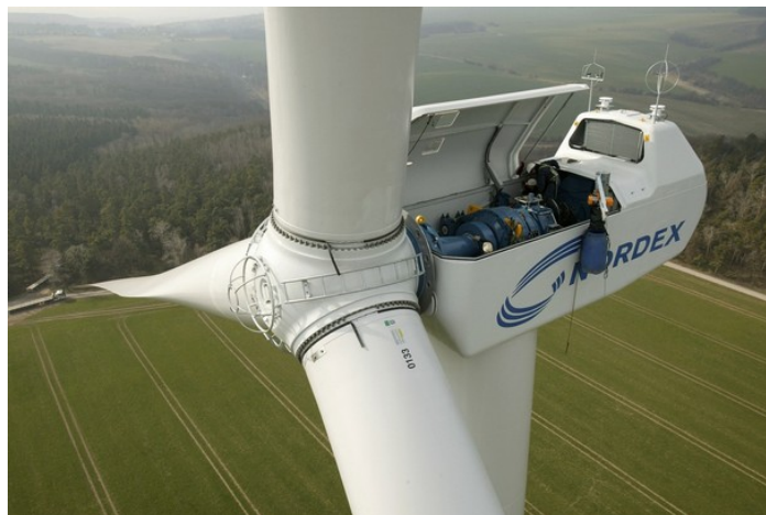
Figura 2.3 Aerogenerador de 2.3 MW instalado a una altura de 100 m en Halle, Alemania.
