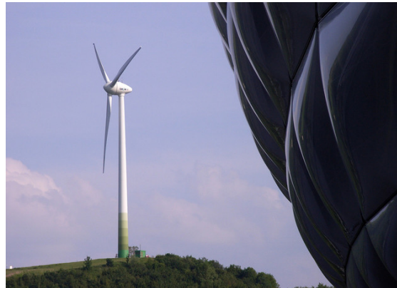
Figura 4.1 Aerogenerador instalado en una zona urbana, en las cercanías del estadio “Allianz Arena” en Múnich, Alemania.
