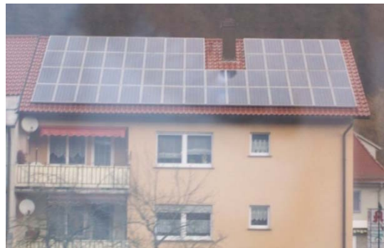
Figura 1.4 Proyecto fotovoltaico residencial en el Estado Federal de Baviera en la República Federal de Alemania.
