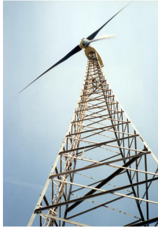
Figura 4.4 Deben evitarse las torres de elementos estructurales. Fuente: Propia.
