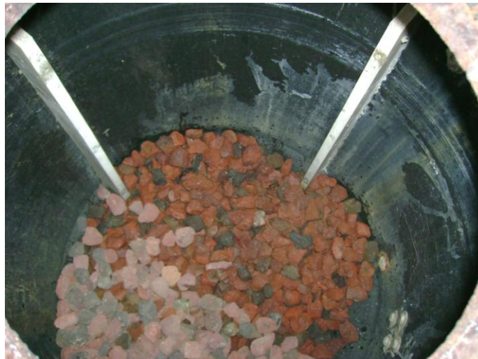
Figura 3.13. Esquema del sistema de biofiltro anaerobio de lecho sumergido en intermitente - SBR
