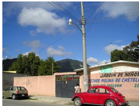
El sistema de alumbrado publico esta cubierto en su totalidad, con elementos de postiería a cada 30 mts. máximo.
