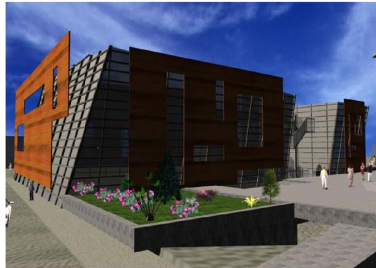
Vista desde la Cerrada. Del Pedregal
