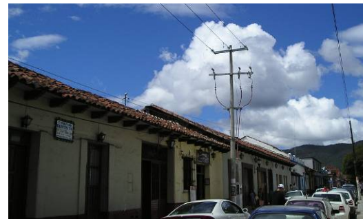
Tipología de construcciones en el Barrio de la Merced.
