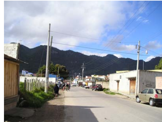
Vista de la Av. de los sumideros, que brinda servicio directo a nuestro predio con dirección norte sur, en ambos sentidos.
