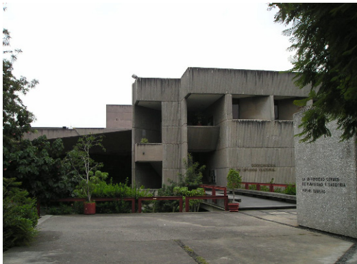
Edificio de coordinación y difusión cultural del centro cultural universitario en C.U., en donde se realizan las actividades administrativas.
