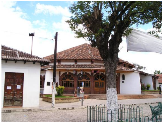
Edificio complementario a la casa de la cultura, ubicado en la antigua casa del carmen.
