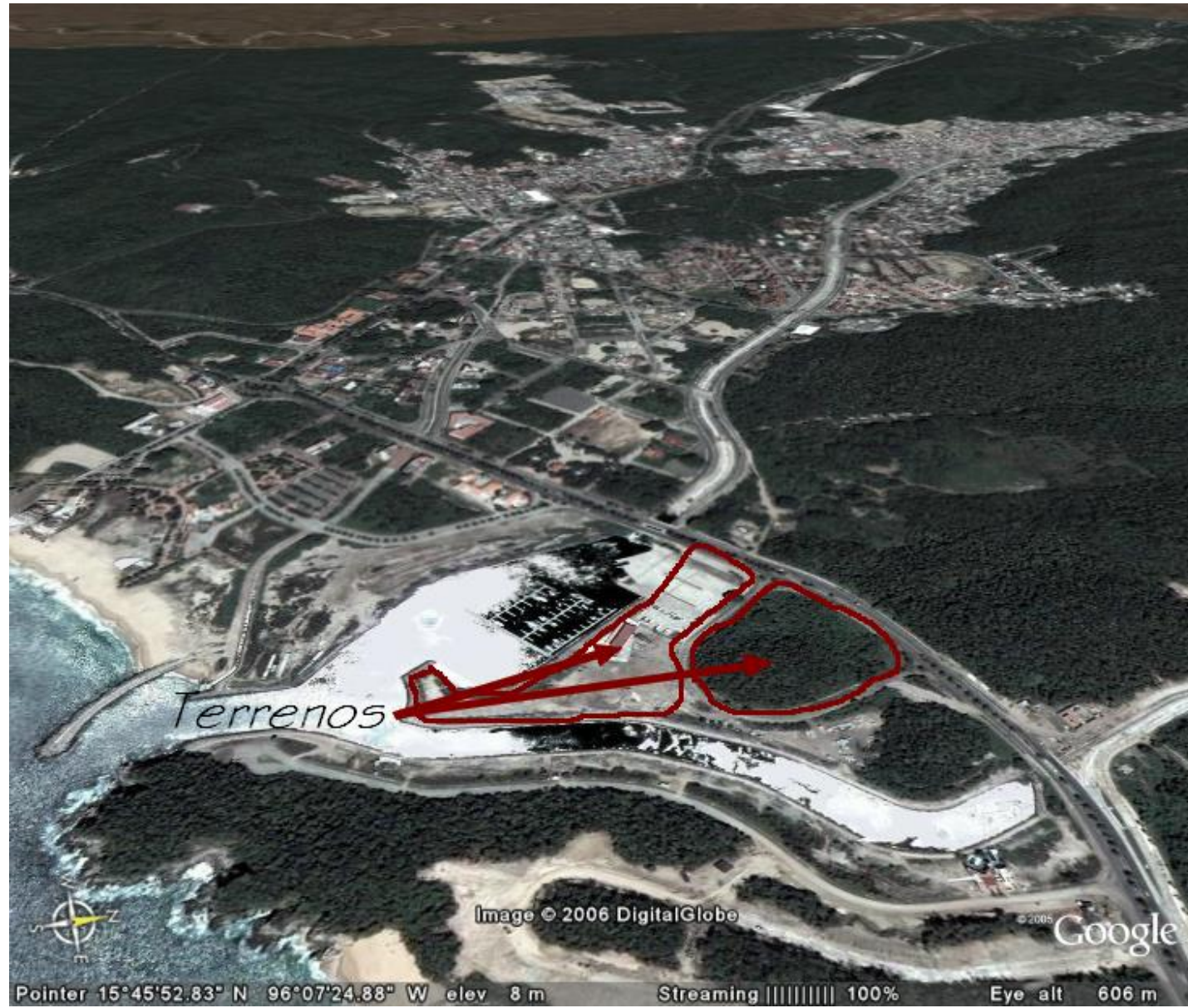
Vista aérea desde el Oriente, Fuente: Google Earth
