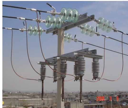
Figura 1.8. Cuchillas Horizontales
