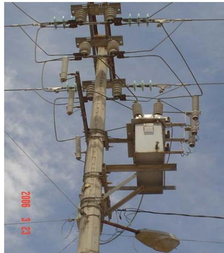
Fig. B Instalación de medios de seccionamiento para reducción del TIU
