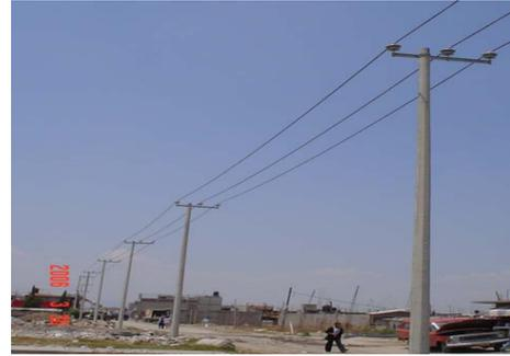
Fig. 1.3. Alimentadores primarios en 23 kV.
