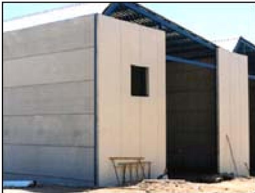
**Figura 7.8** Disposición vertical de las losas extruidas en fachadas.
