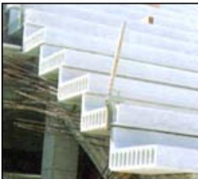
**Figura 7.10** Gradas construidas a base de losas alveolares.
