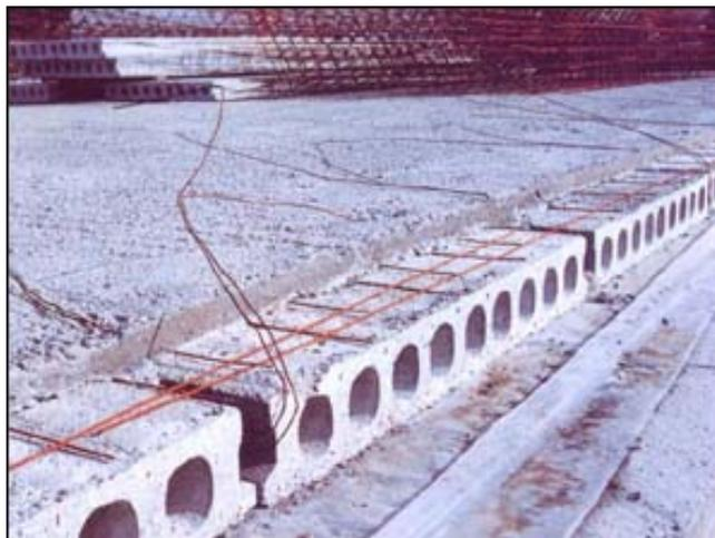
**Figura 5.1** Aspecto de los extremos de las losas alveolares en un sistema de piso.
