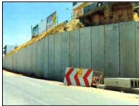
**Figura 7.1** Imagen donde se muestra la aplicación de la losa extruida como contención de tierras.
