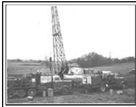
FIG. I.1 Primer fracturamiento hidráulico en Estados Unidos en 1948.
