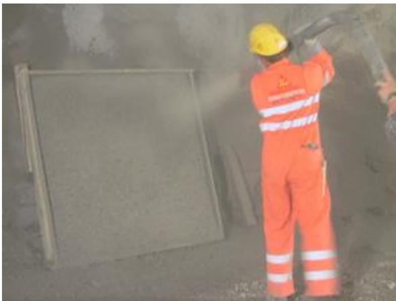
Figura 17. Colocación concreto lanzado.
