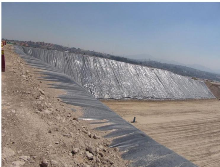
Figura 14. Geomembrana en talud.
