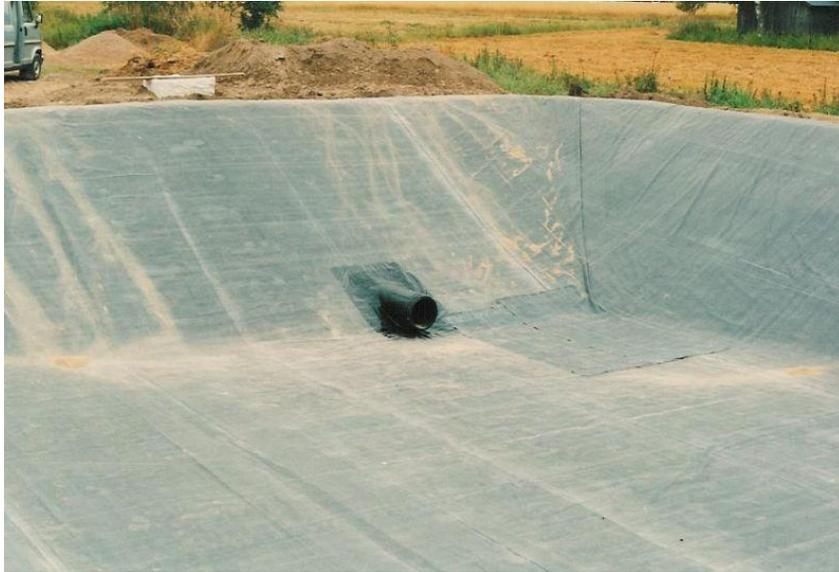
Figura 16. Colocación de tubo de descarga.
