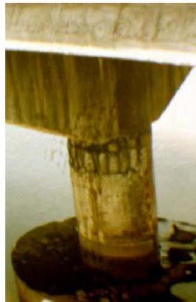
**Figura 1.9** Falla por flexión-cortante
