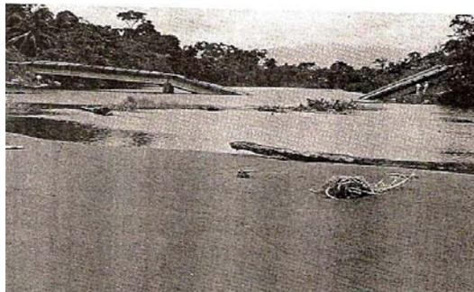
**Figura1.2** Pérdida de apoyo de la Subestructura (Costa Rica 1990)
