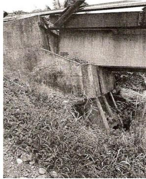
**Figura1.4 Rotación del estribo (Costa Rica 1990)**
