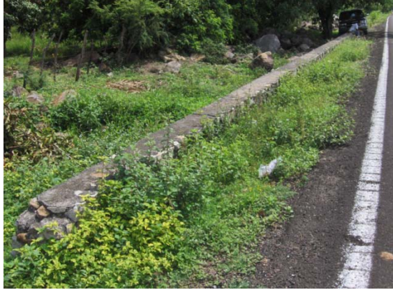
Imagen 3.7 Existe un muro de contención a un costado del camino.
