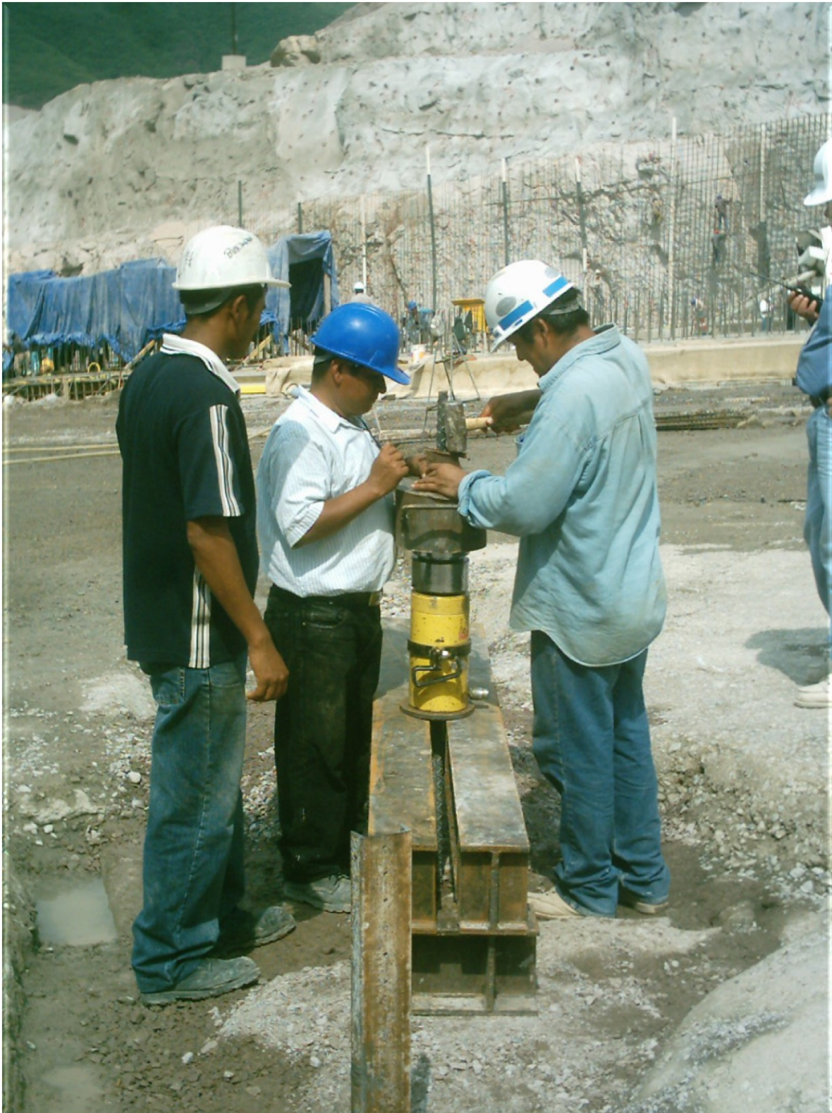
Foto IV.7.3 Acomodo final de vigas de reacción, gato hidráulico, rotulas y dado con mordazas.
