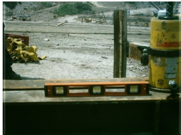
Foto IV.7.2 Nivelación de vigas de reacción
