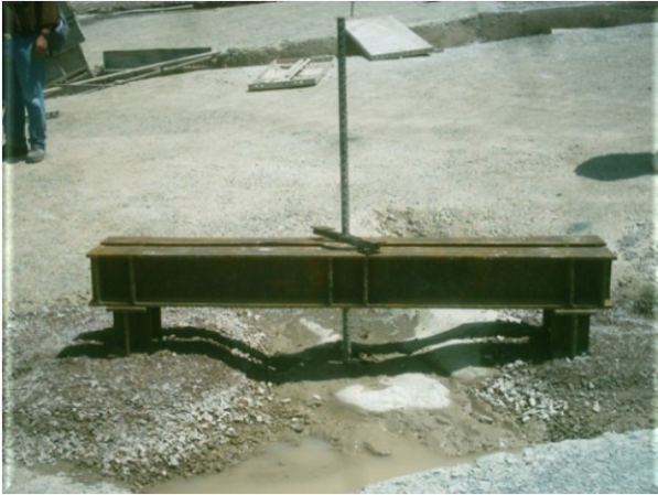
Foto IV.7.1 Vigas de reacción
