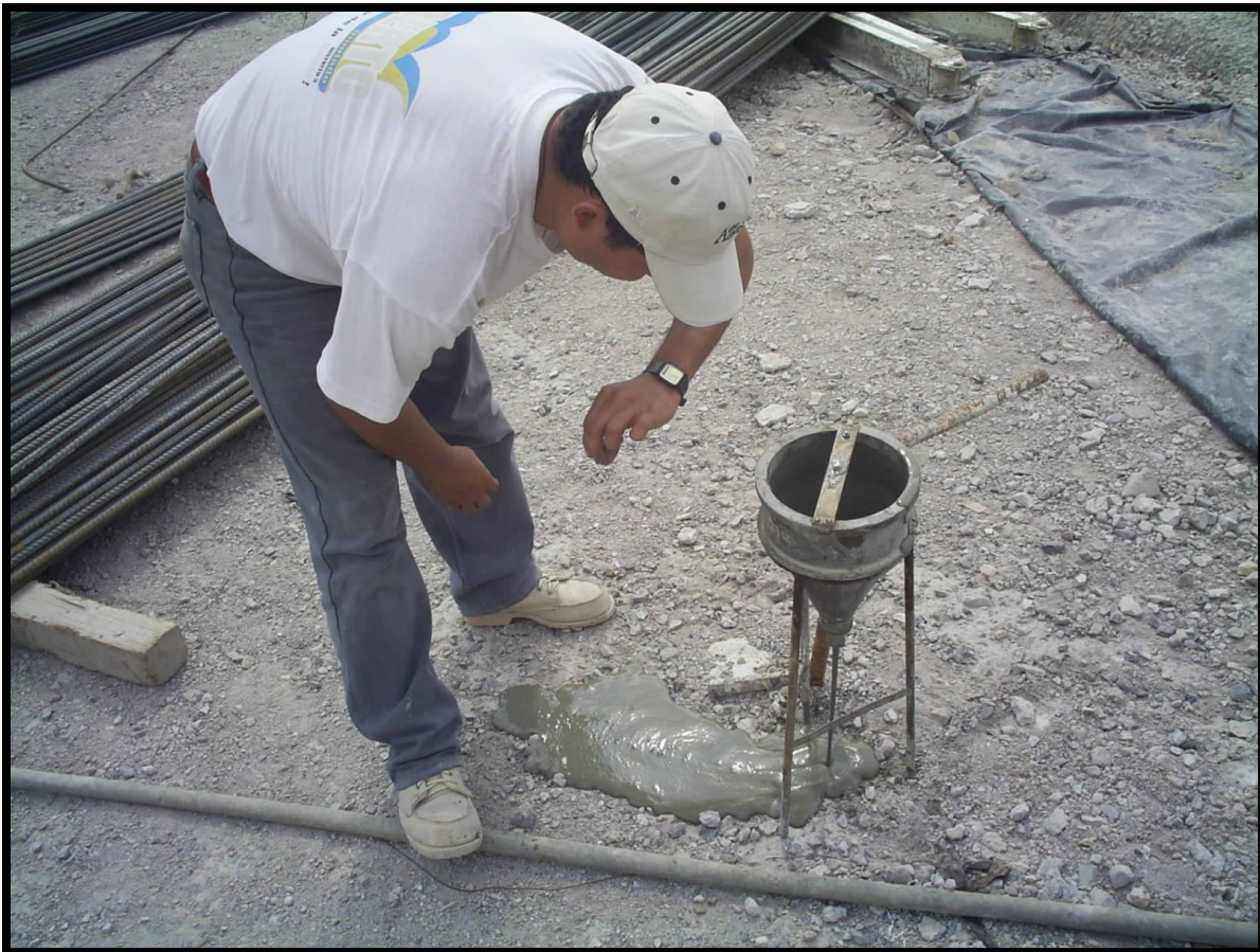
Foto IV.3.2 Prueba de fluidez de mortero para inyección de anclas.
