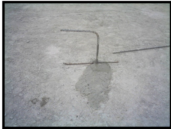
Foto IV.2.5 Ancla de gancho de 1” Ø x 4m en piso para losa de canal de descarga.
