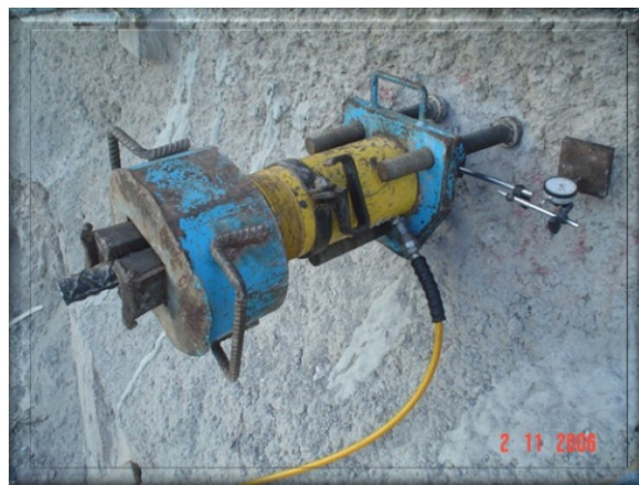
Foto III.5.3.1 Prueba de extracción de ancla
