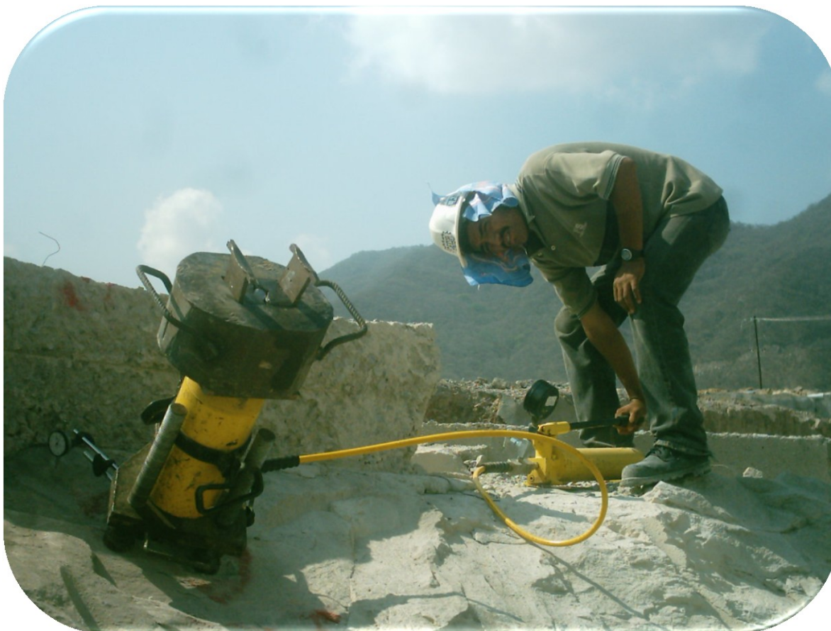
Foto IV.5.3 Prueba de extracción de ancla. Dando carga al ancla.
