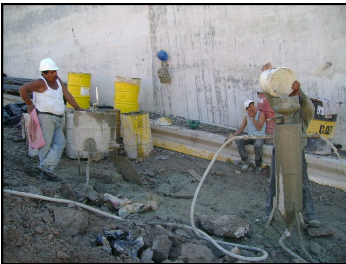
Foto IV.3.1 Mezcla de mortero en agitador de mano y llenado en satélite para inyección de ancla.
