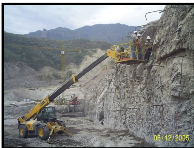
Foto IV.2.3 Manipulador utilizado para colocación de anclas y pruebas de extracción de anclas
