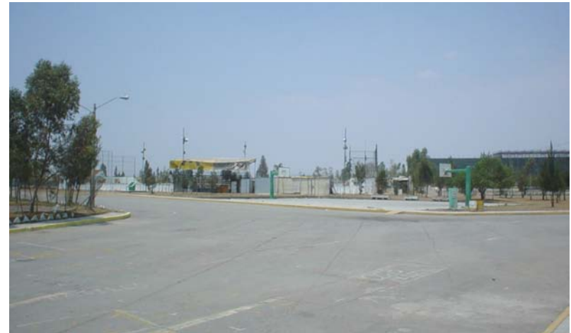
Vista frontal del terreno
