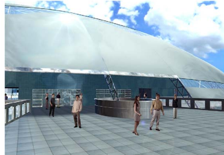
Explanada de acceso al público
