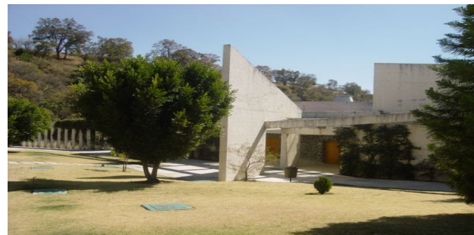
FOTO: Centro Cultural, Zona de talleres y pasillo para acceder a sanitarios
