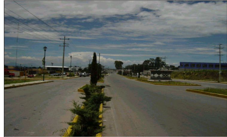
FOTO: Acceso principal entrada por carretera Tlaxcala Ver.
