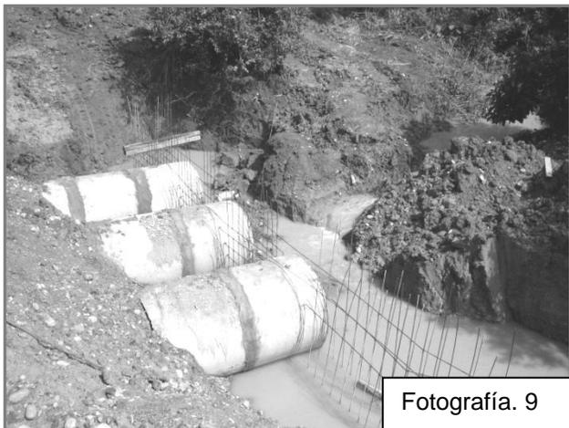
Las alcantarillas se colocarán en zanjas o se pueden tender sobre la rasante y cubrirlas con un terraplén. En la construcción con zanjas, se realiza el trazo y nivelación. En seguida se marca y se estaca sobre el terreno, y posteriormente se continúa con la excavación, la cual se realizará con equipo (retroexcavadora) y afine a mano.
