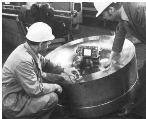
Figura No. 3: Ultrasonido industrial para fines de control de calidad
