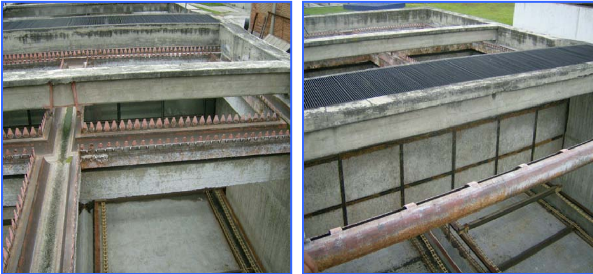
Fotografía 3.22 Sedimentador secundario
