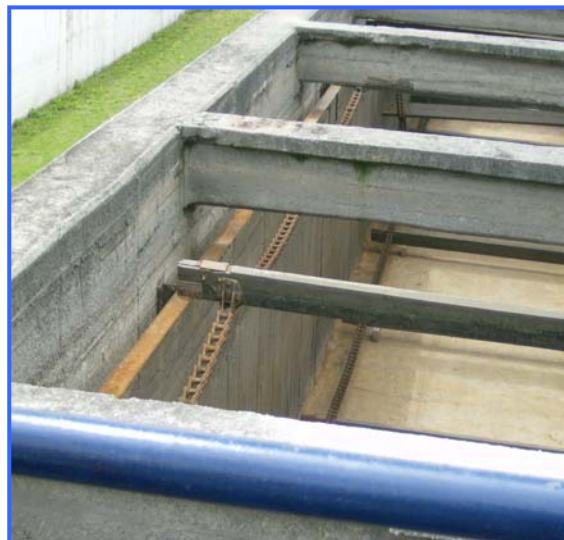
Fotografía 3.21 Tanque sedimentador secundario
