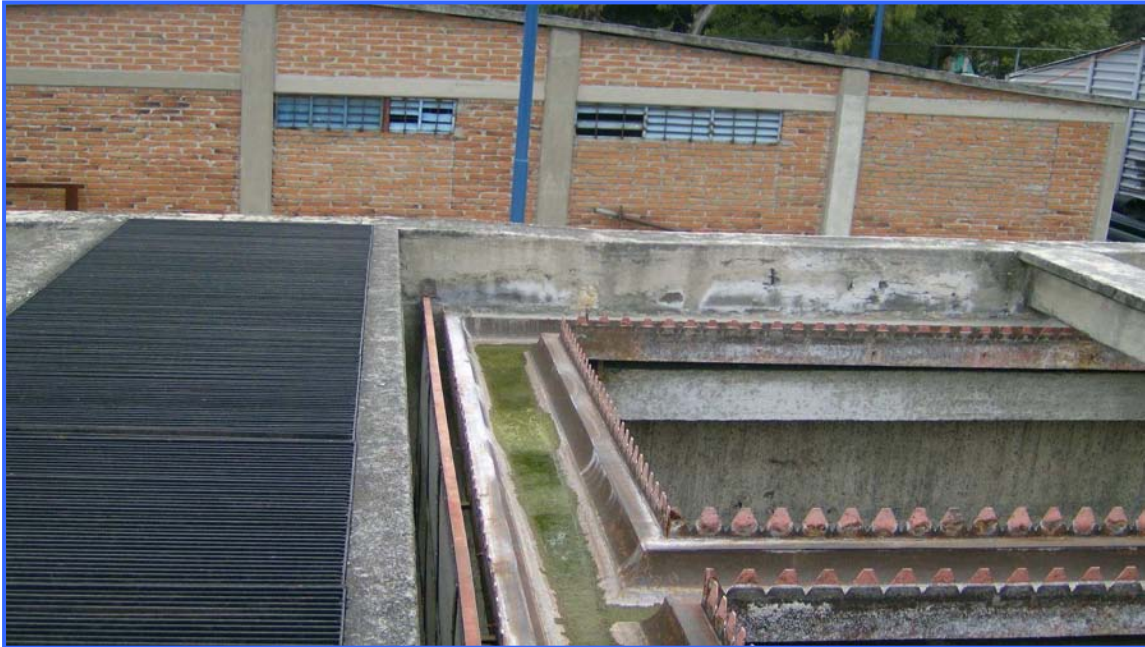
Fotografía 3.24 Canaleta en el tanque sedimentador secundario
