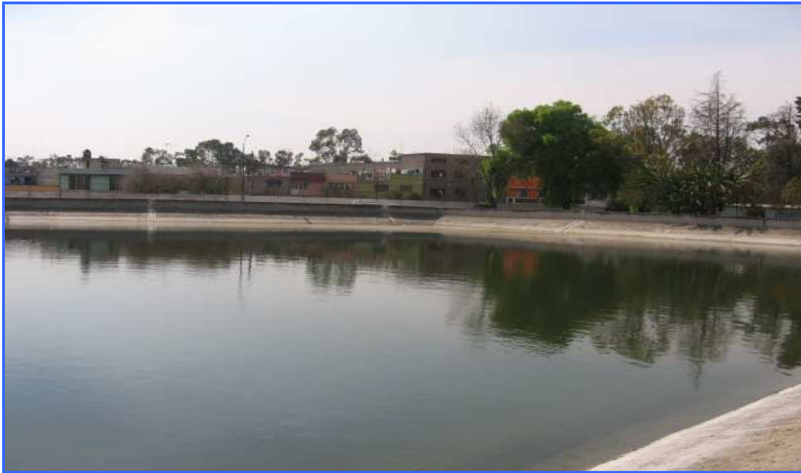
Fotografía 3.31 Laguna de almacenamiento de agua tratada
