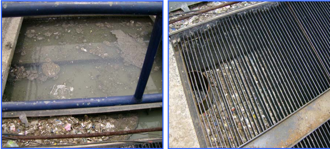
Fotografía 3.8 Basura Recolectada por el Tanque Sedimentador Primario de la Planta
