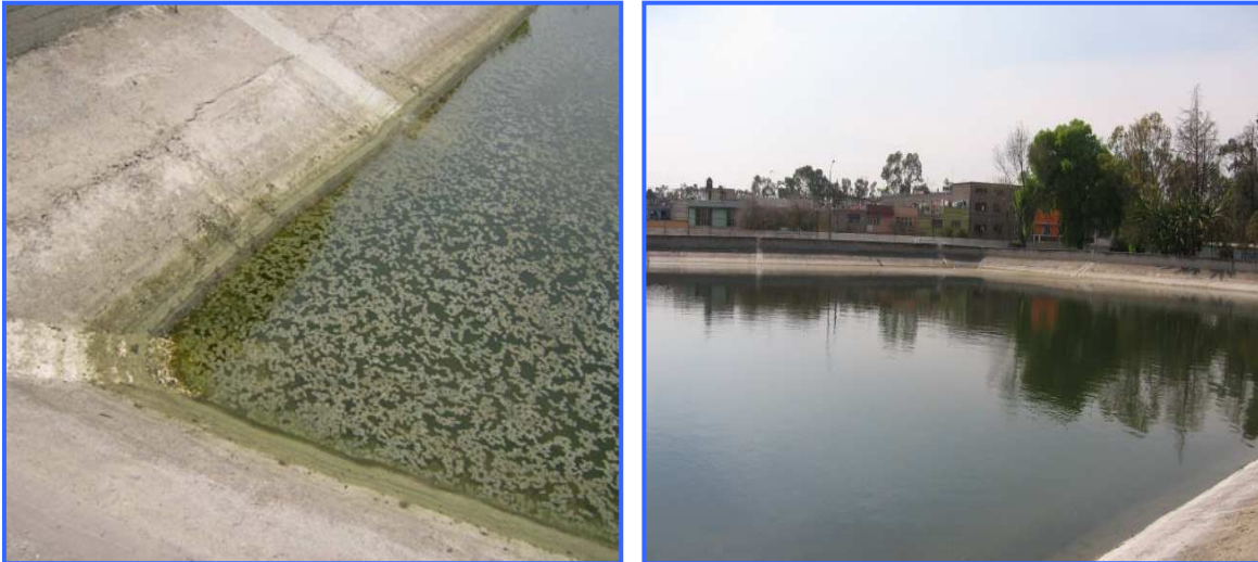
Fotografía 3.4 Laguna de almacenamiento de agua de la Planta de Tratamiento Aragón
