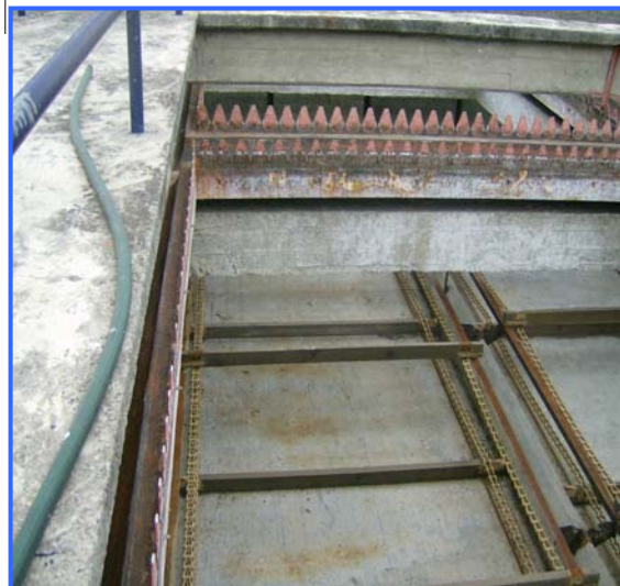
Fotografía 3.20 Tanque sedimentador secundario
