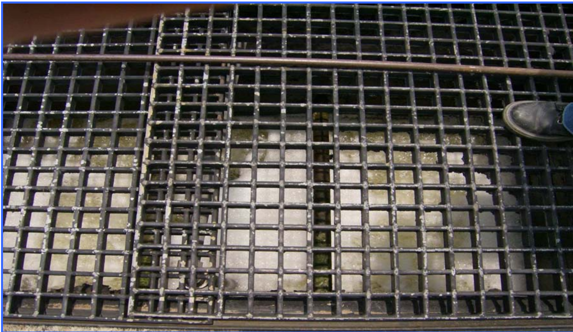
Fotografía 3.28 Tanque de aplicación de cloro
