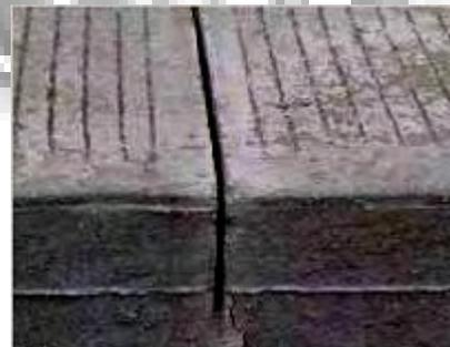
Corte hasta 1/3 del Espesor
