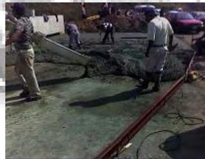
Vaciado de Concreto MR 40 kg/cm<sup>2</sup>
