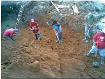
Relleno de Excavación con Tepetate
