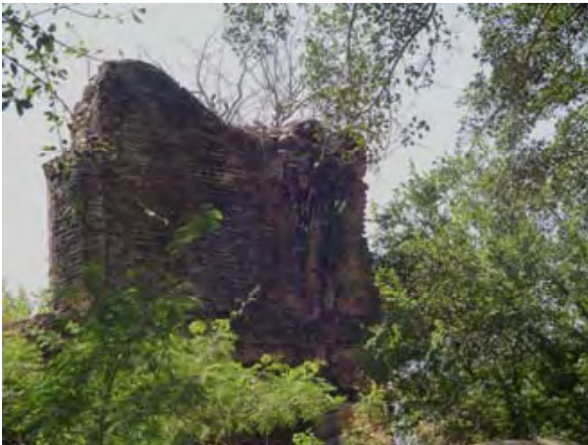
29. Muro a base de piedra y ladrillo de barro. Templo en ruinas de Pochutla Actual colonia Julián Grajales, municipio de Chiapa de Corzo. Foto: autor, 2007
