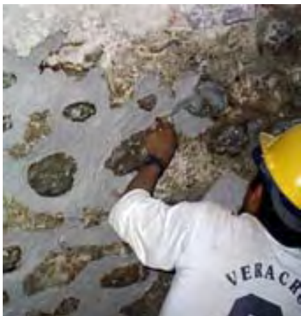
16. Técnico aplicando revestimientos. Foto: autor, 2007.
