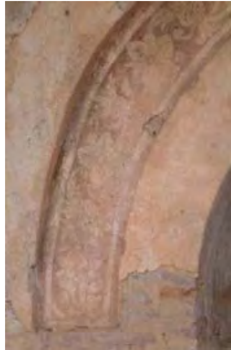
76. Vestigios de aplanados con ornamentos esgrafiados. Enmarcan un arco del convento de Tecpatán. Foto: autor, 2007
