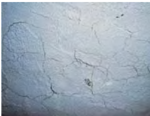
7. Primera capa de revestimiento, el que por deshidratación se agrieta, sobre este se colocará otro tendido.
