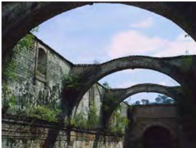
6. Nave del templo de Tecpatán, se ven los arcos fajones y vestigios de arcos formeros, al fondo está el presbiterio. En estos paramentos aun es posible ver restos de aplanados con decoración, tanto esgrafiada como de pintura mural.
