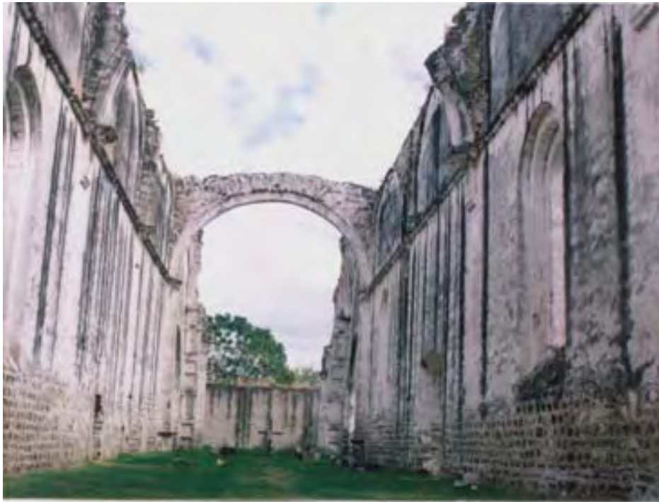
8. Nave del templo de Copanaguastla. Foto: autor, 2004
