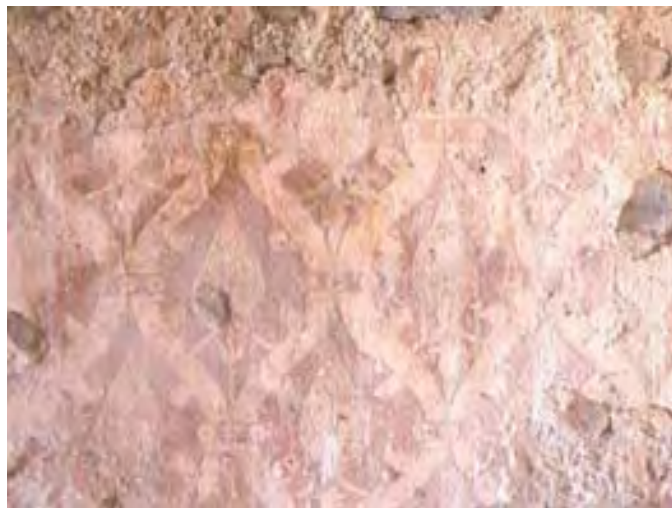
74. Ajaracas en el local de la escalera. Convento de Tecpatán. Foto: autor, 2007
