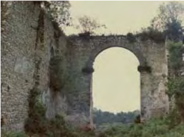
26. Ruina del templo de San Marcos, Sibacá. Actualmente la maleza ha invadido totalmente al monumento. Foto: autor, 1990
