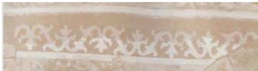
28. Detalle, esgrafiados en la torre de Tila. Foto: autor, 2000
