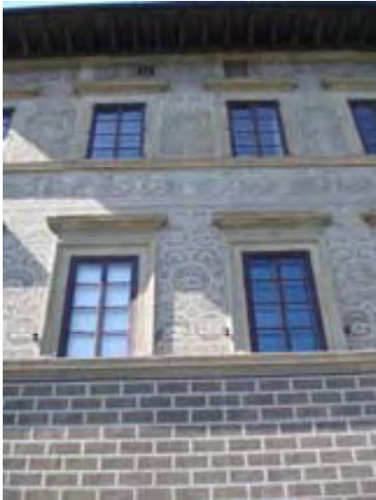
108. Fachada decorada con esgrafiados de un palacio de Florencia, Italia.
