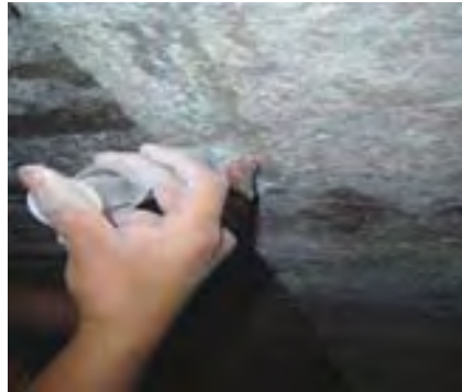
12. Aplicación de inyección, casina mas lechada de cal viva para sujetar aplanados sueltos o separados del soporte. Foto: autor, 2006
