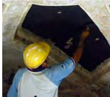
8. Aplicación de revestimiento en el intradós de adovelados del convento de Tecpatán.
