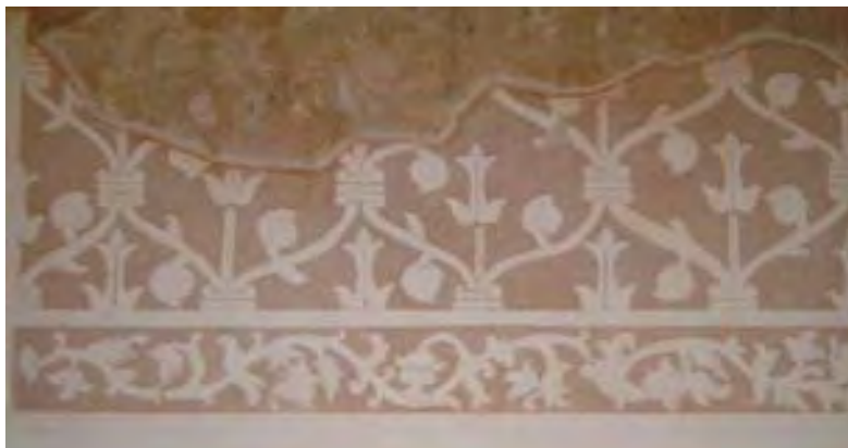
81. Ajaracas, técnica de esgrafiado, pertenece al paramento sur de la crujía sur. Convento de Chiapa de Corzo. Foto: autor, 2006
