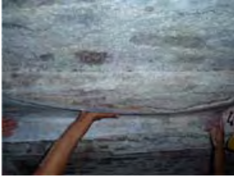
13. Aplicación de velados en aplanados o revestimientos sueltos. Esta imagen pertenece al intradós de una bóveda del convento de Tecpatán.
