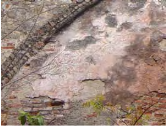
68. Esgrafiados en la zona superior del paramento norte de la nave. Templo de Tecpatán Foto: autor, 2006
