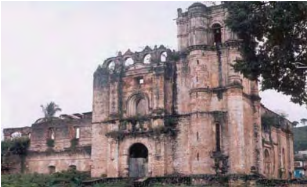
18. Fachada principal. Convento de dominico de Tecpatán. Foto: autor, 2007
