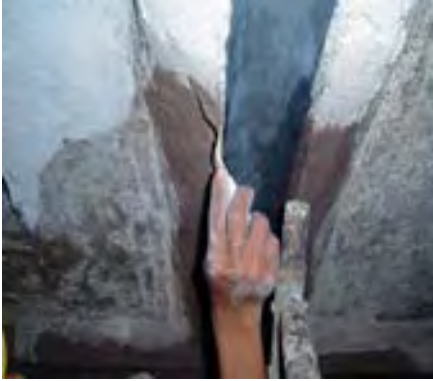
10. Detalles del proceso constructivo. Restitución de una nervadura con revestimientos ornamentales. Convento de Tecpatán. Foto: autor, 2006
