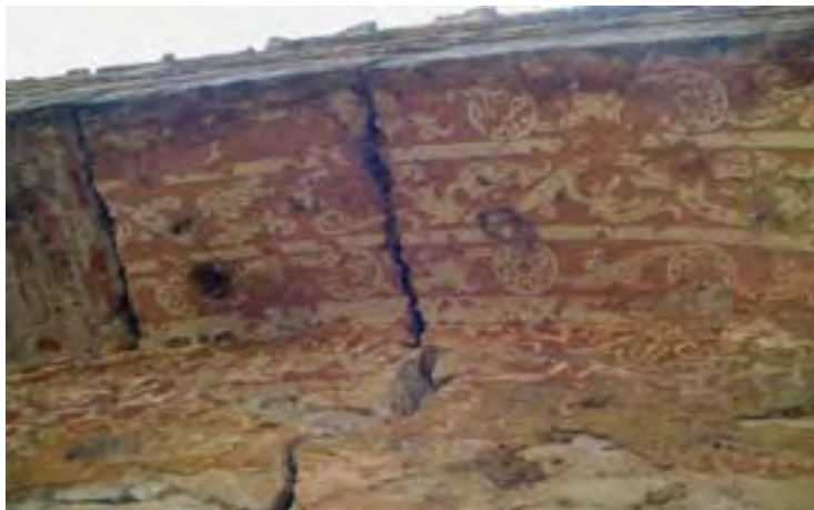
30. Ornamentación con técnica de esgrafiados. Intradós de un arco de la ruina de Pochutla, Chiapa de Corzo. Foto: autor, 2007
