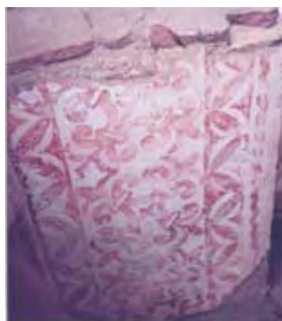
107. Dibujo a base de pintura y esgrafiado, vestigio de columna de la catedral de Antigua Guatemala. Foto: autor, 1999
