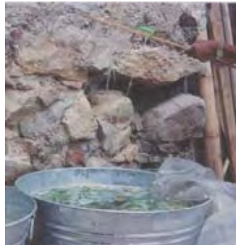
6. Recipientes en el que se coloca agua más trozos de nopal para que suelten baba, este líquido viscoso es utilizado en la pasta para revestimientos.
