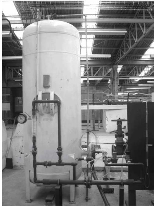
**Figura 5.5.** Sistema neumático (tanque acumulador y dispositivos de regulación).
