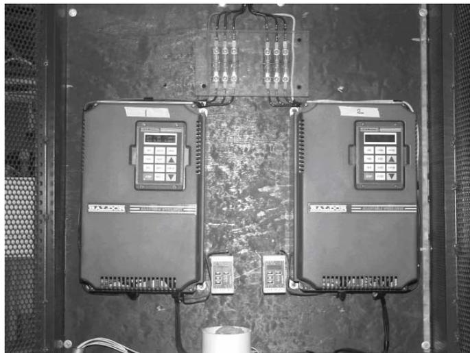
Figura 5.3. Variadores de frecuencia para el control de las bombas.
