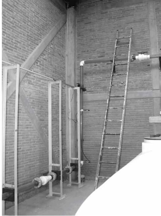
Figura 5.8. Tramo vertical ascendente, línea de salida y válvula de control.
