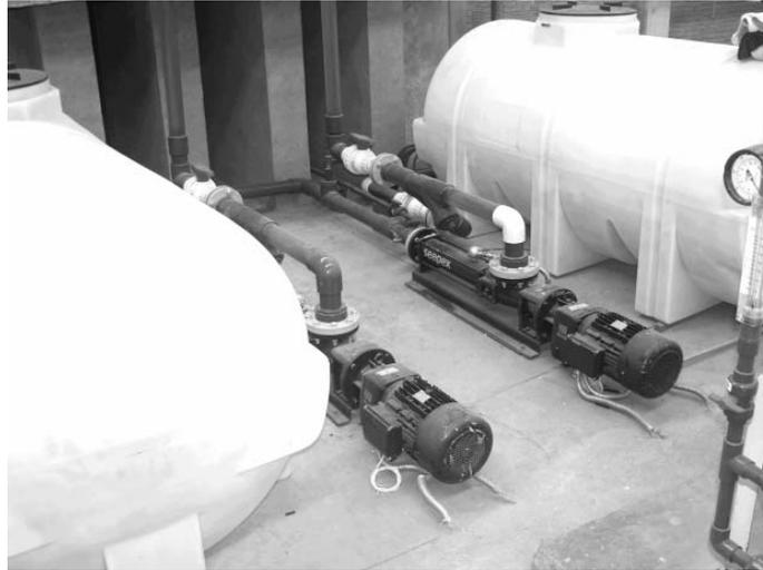
Figura 5.2. Tanques de almacenamiento y bombas de cavidad progresiva.
