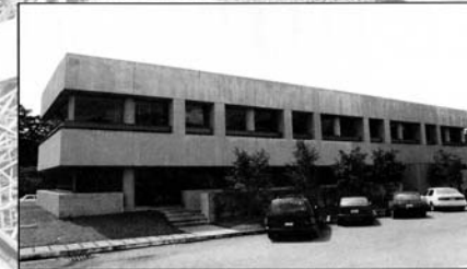
Edificio del área administrativa y oficinas.
