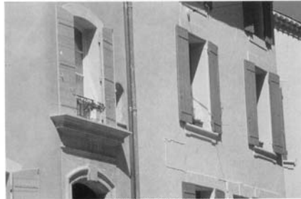
Las tendencias de la construcción moderna.
