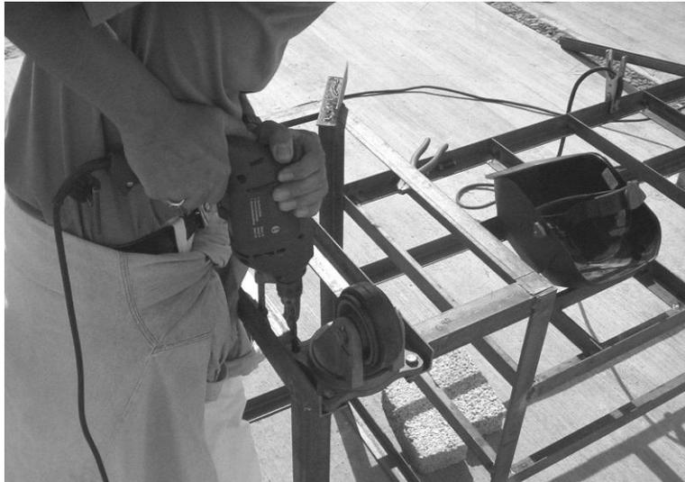
**Figura 4.11.** Perforación para sujetar ruedas.
