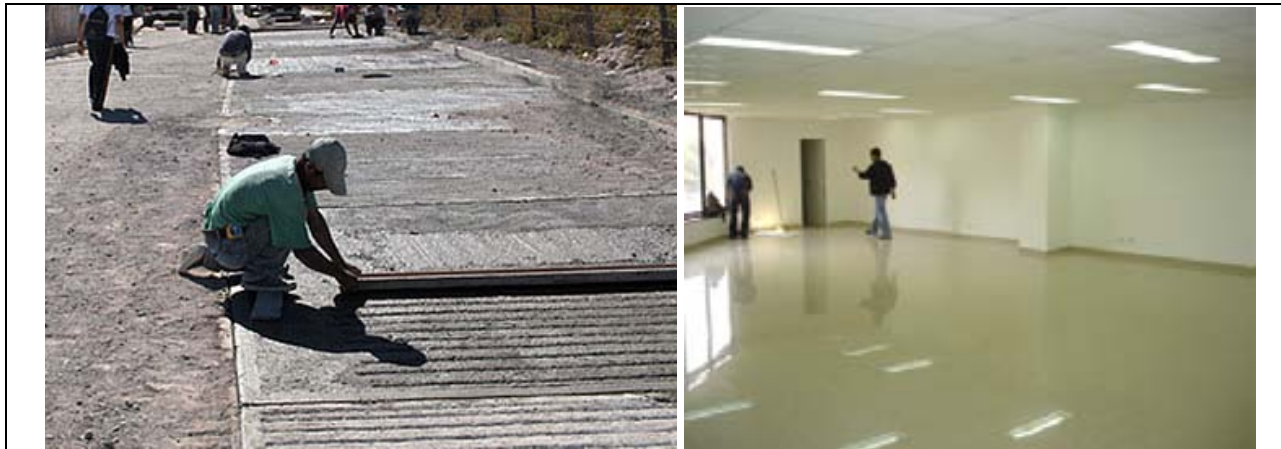
Fig.44 Acabados en piso. Izquierda, concreto estriado. Derecha, Porcelanato
