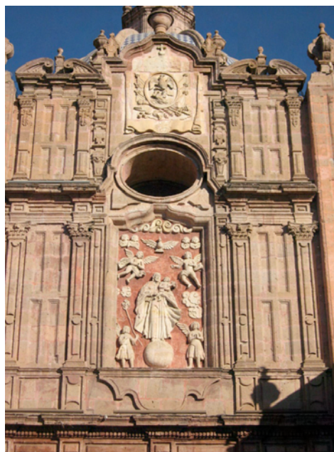
Fachada poniente (detalle)
