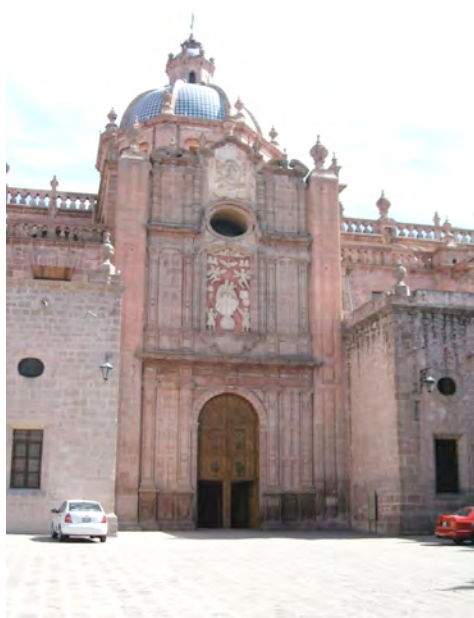
Fachada poniente: Patrocinio de San José
