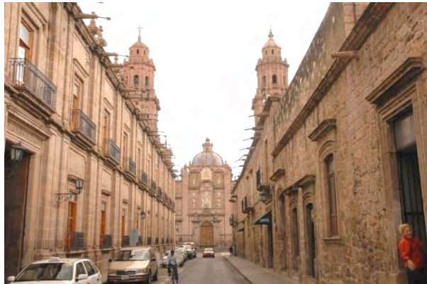
Remate de la calle del obispado: Iglesia Catedral
