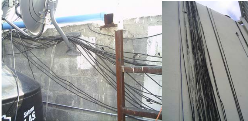
Figura 4.64. Trayectorias de cable
