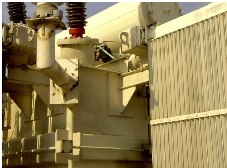
FIGURA 6.- Ubicación de un relevador Buchholz en un transformador real.
