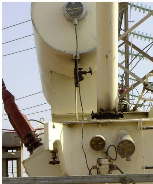
FIGURA 8.- Ubicación de un relevador de sobrettemperatura en un transformador
