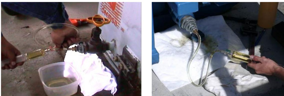
FIGURA III-17.- Toma de muestras de aceite a transformadores.
