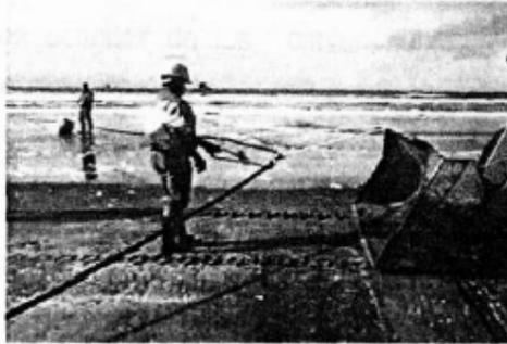
Figura 3. 13 Trabajos de Instalación del cable submarino a la orilla del mar
