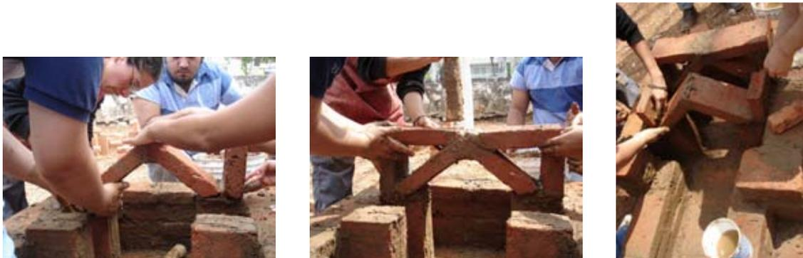
En el cuarto nivel también se construyó un triángulo, siendo éste la unión del túnel para la entrada de la leña y el horno, resolviéndolo de manera similar que los dos
