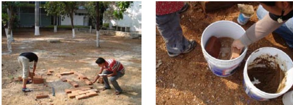
Para colocar cada ladrillo, primero se remojaba en una cubeta con agua mientras, en el espacio donde iba a ir colocado, se depositaba barbotina en abundancia en la parte de en medio, una vez situado el ladrillo, se le daba un par de golpes al medio con un palo grueso, para asentarlos bien. Los orificios que quedaban sin barbotina se rellenaban en ese momento.
