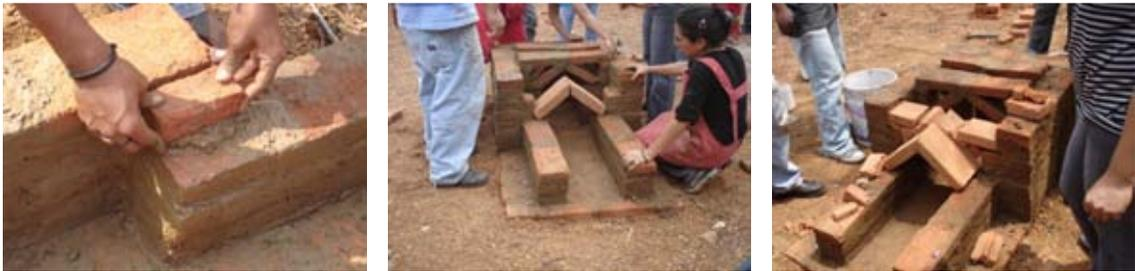
El túnel de la leña, se siguió construyendo manteniendo el tamaño resultante de la entrada. La medida fue de; dos ladrillos horizontales de cada lado hacia delante y sobre éstos, se pusieron dos niveles más. Ya en el tercer nivel, se colocaron encima de éstos, cuatro ladrillos con corte en 45° para cada lado siguiendo el triángulo. Una vez terminada la entrada de la leña, se reforzaron ambos lados de la entrada con dos ladrillos colocados horizontalmente de cada lado en el hueco que quedó libre.
