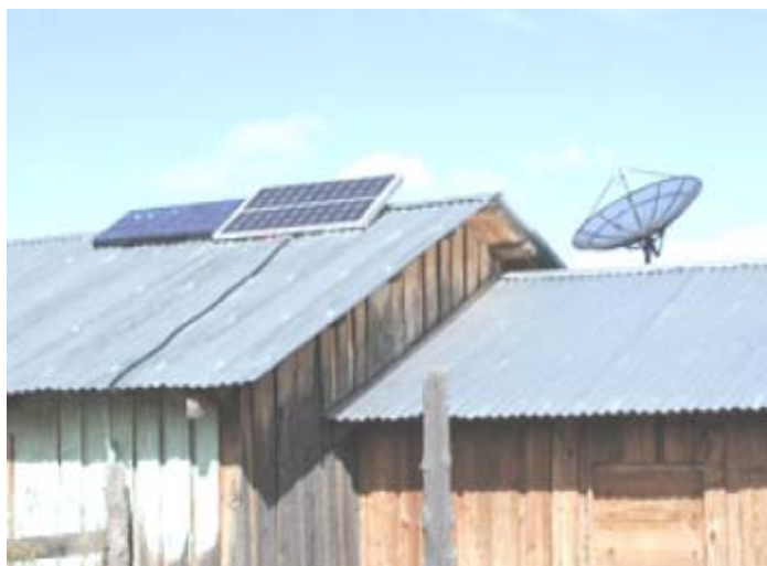
Telesecundaria con energía fotovoltaica en Durango, 1976, México.
