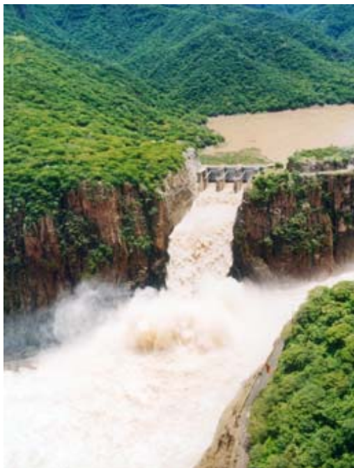
Central Hidroeléctrica M. M. Dieguez (Santa Rosa) Amatitlán Jalisco, México. Fuente: http://saladeprensa.cfe.gob.mx/banco/images/portada/4/SantRosa26C.jpg
