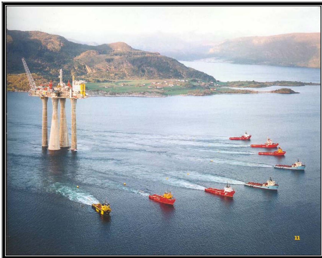
Fig. A13.2 plataforma de concreto
