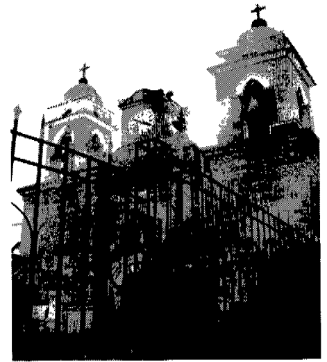
FOT 3.48 Parroquia de San Pablo Apóstol, Chimalpa
