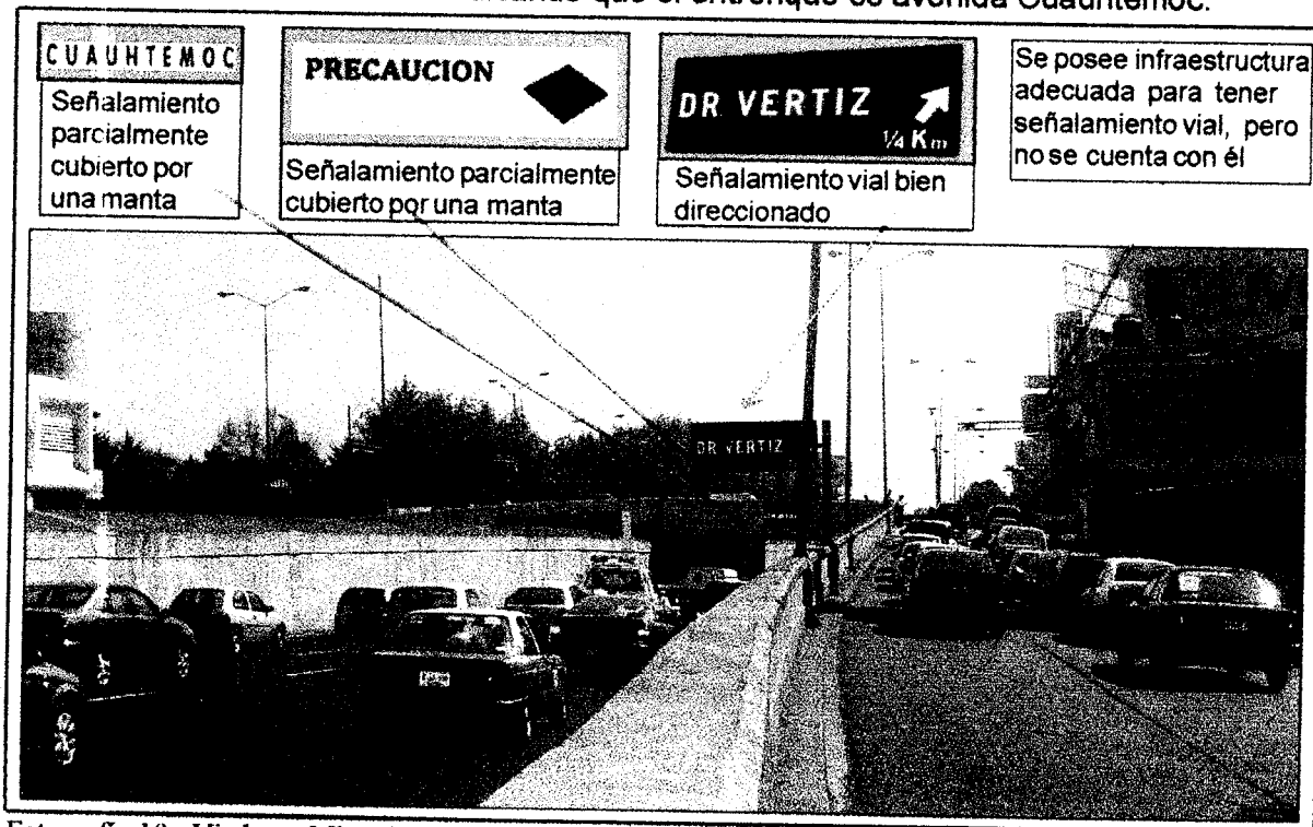
Fotografía 10. Viaducto Miguel Alemán dirección avenida Revolución, al cruce con el Eje 1 Poniente.
