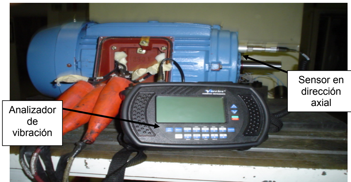
Figura 4.13 Medición de vibración en dirección axial del lado flecha
