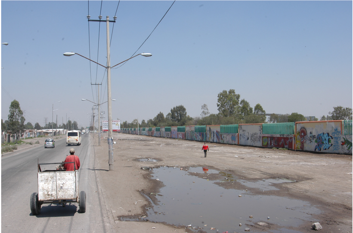
Avenida Bordo de Xochiaca. Derecha, deportivo Neza antes de iniciar obras. Foto: Jorge Martínez
