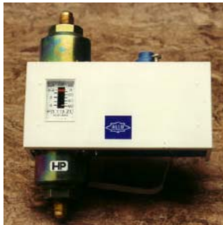
Figura 10 Control de presión para el aceite.
