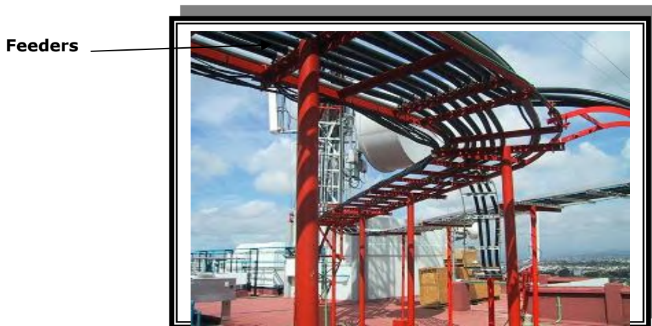
Fig. 3.2 Los Feeders que van del equipo al sistema de antenas.
