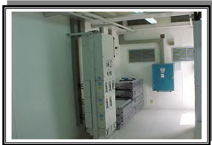
Fig. 3.3 El equipo de Fuerza y las Batería.
