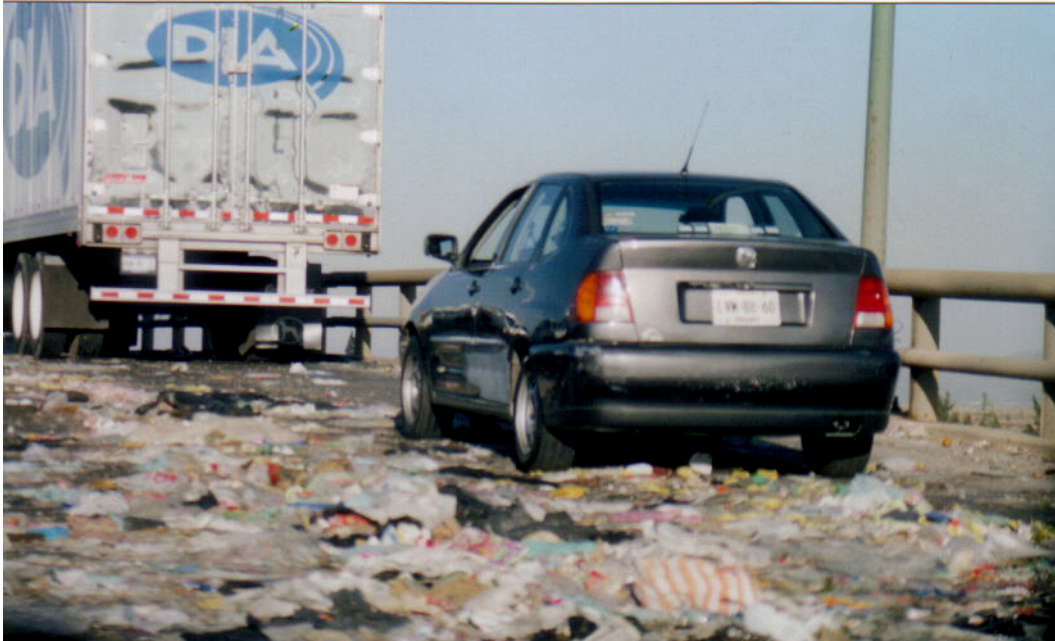
Puente Bordo Poniente
