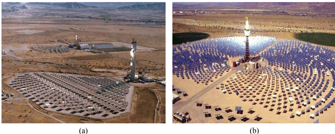
Fig. 1.2 Hornos solares: (a) Horno solar en Almería España, (b) “Solar Two” la cual es una torre de concentración en el Desierto de Mojave, California.
