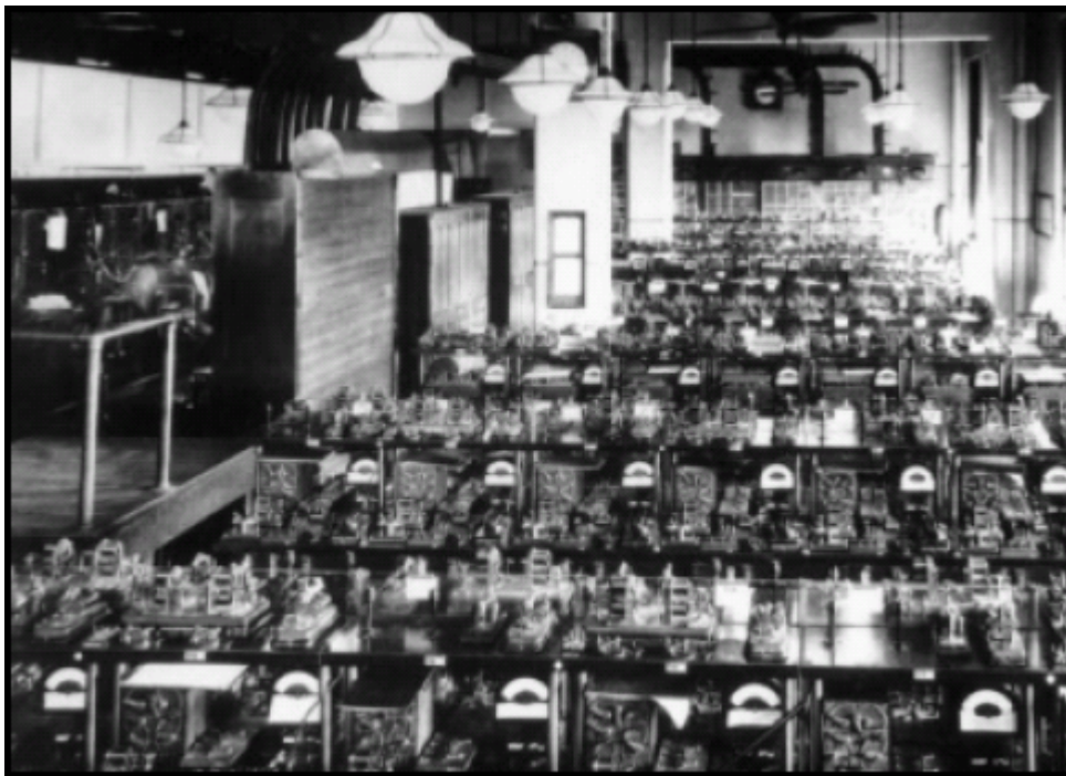
Figura 1.1 Aspecto del edificio de una de las primeras redes telegráficas del mundo
