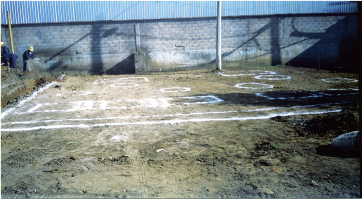
Figura C.4.- Trazo de los perímetros de las cimentaciones de los componentes del filtro (se utiliza cal)
