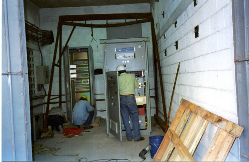
Figura C.24.- Instalación del tablero de control (izquierda) y del interruptor general (derecha)
