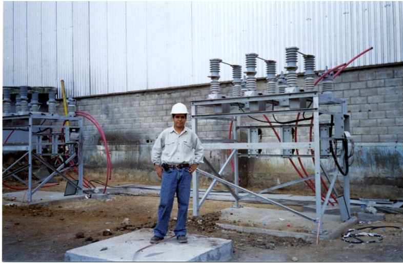
Figura C.10.- Autor de la presente tesis junto con los desconectores de dos secciones de filtrado
