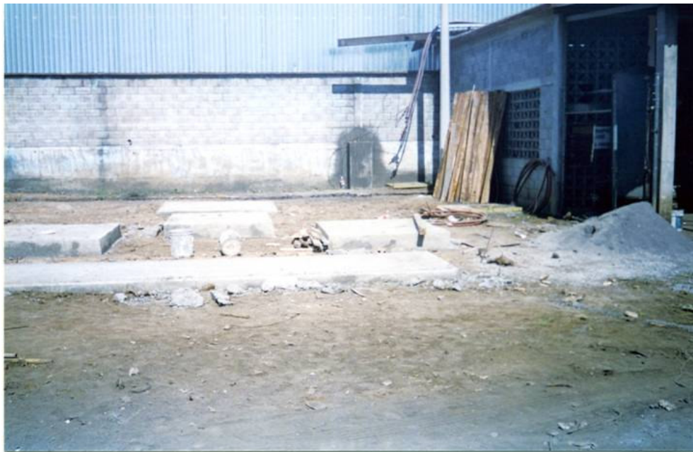
Figura C.9.- Cimentaciones de una sección de filtrado, terminadas
