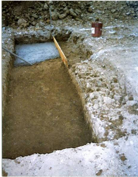
Figura C.6.- Proceso de construcción de una de las tres cimentaciones de los Rack (arreglos) de capacitores. La capa de cemento que se observa, es una primera capa que sirve para aislar otras capas de la cimentación con la tierra.
