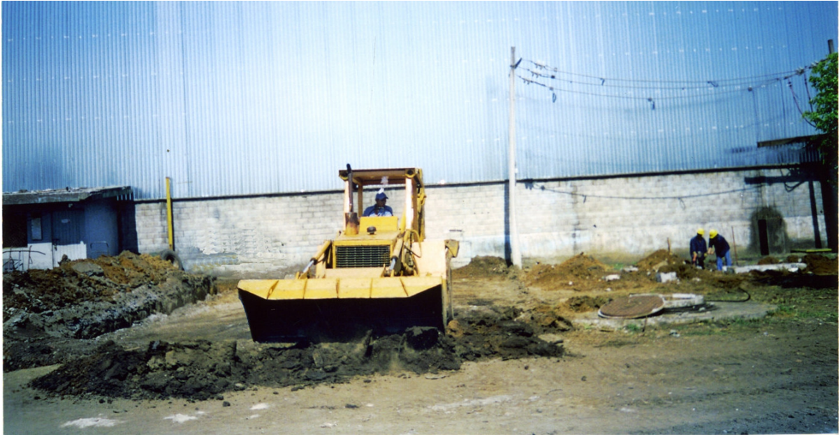
Figura C.2.- Extracción de tierra para nivelar y compactar el terreno. Así también, continúan los trabajos descritos en la figura anterior.
