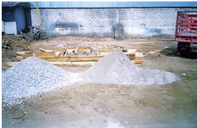
Figura C.7.- Continuación de los trabajos para la construcción de las cimentaciones
