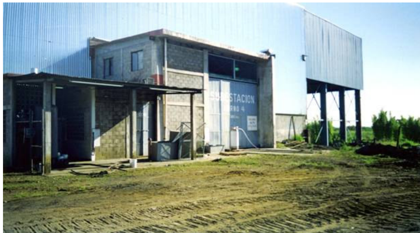
Figura C.23.- Cuartos localizados al lado lateral izquierdo del filtro (en el cuarto de menor altura es donde se localiza el tablero de control y el interruptor general)
