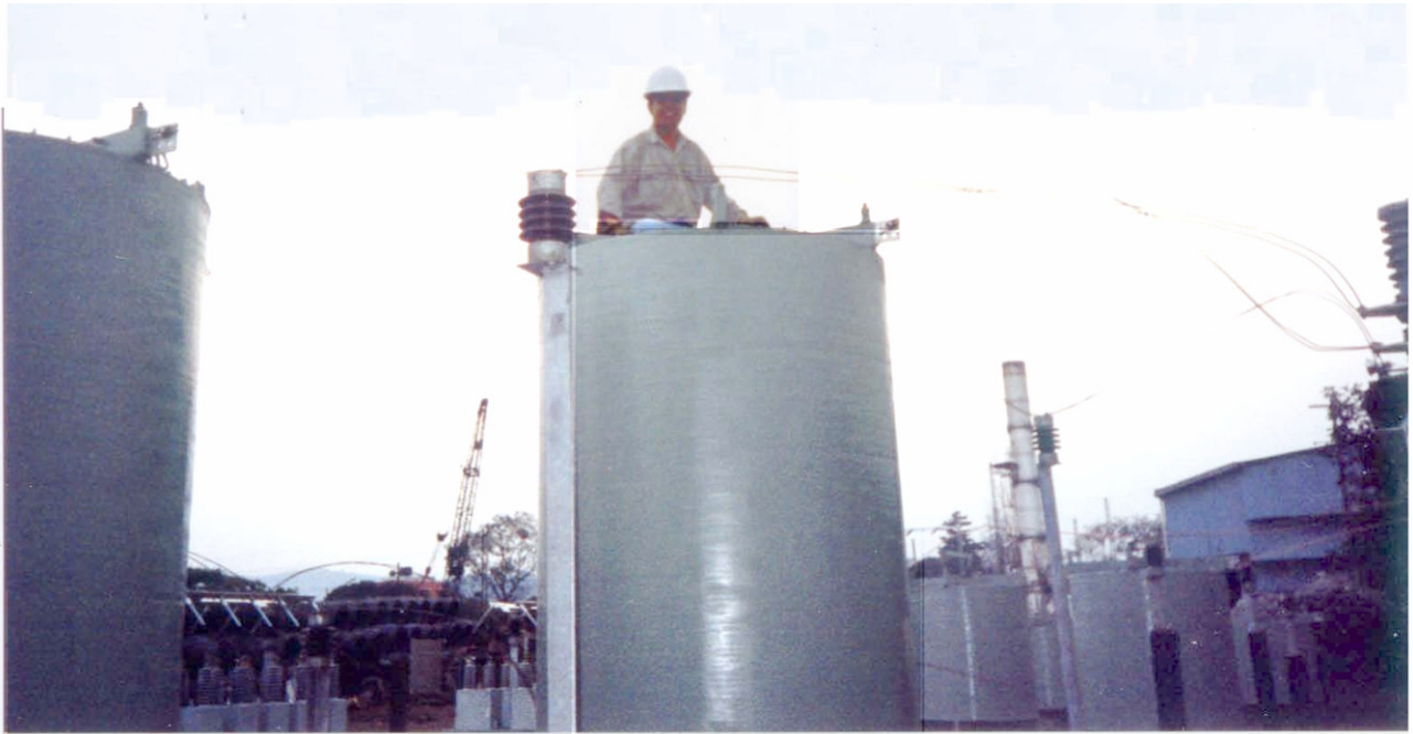
Figura C.20.- Autor de la presente tesis en la parte superior de un reactor núcleo de aire, durante la instalación del mismo
