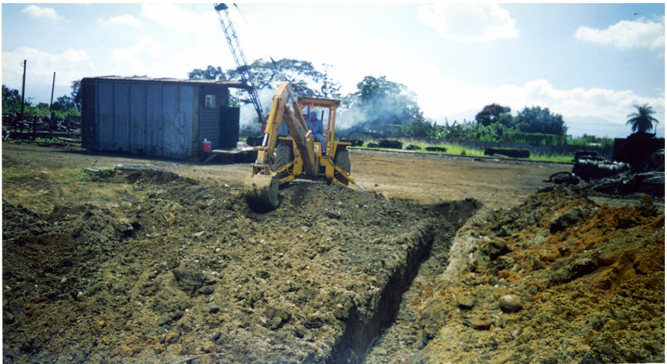
Figura C.3.- Zanja para la instalación del sistema de tierra física (se cavaron zangas en todo el perímetro de terreno, designado para la instalación del filtro)
