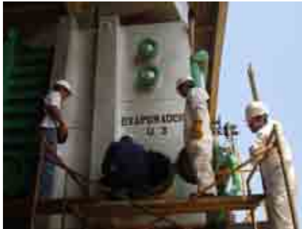
Figura 2.13 Visita a la desaladora MED de Tuxpan [IMPULSA, 2008]
