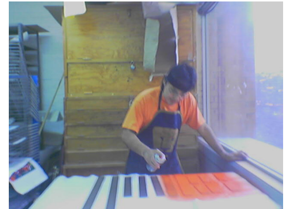
Aplicación de esmalte anticorrosivo.
