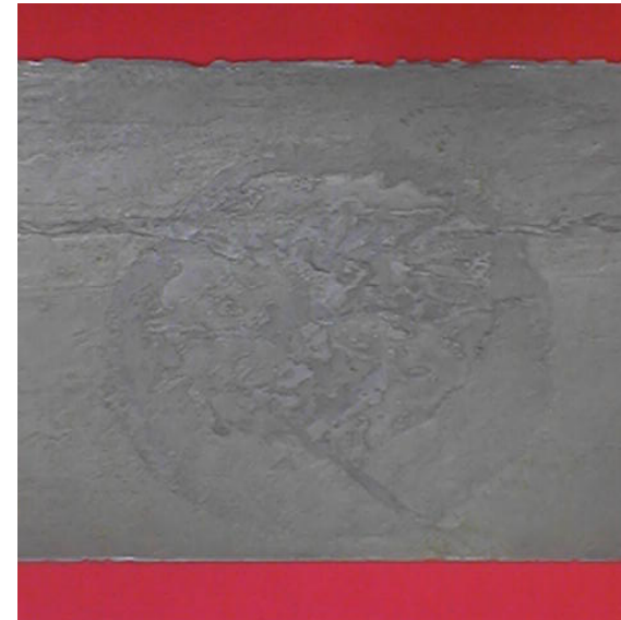
Placas centrales terminadas.
