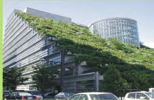
Edificio con naturación de azoteas
