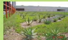
Vista de la terraza del edificio HSBC
