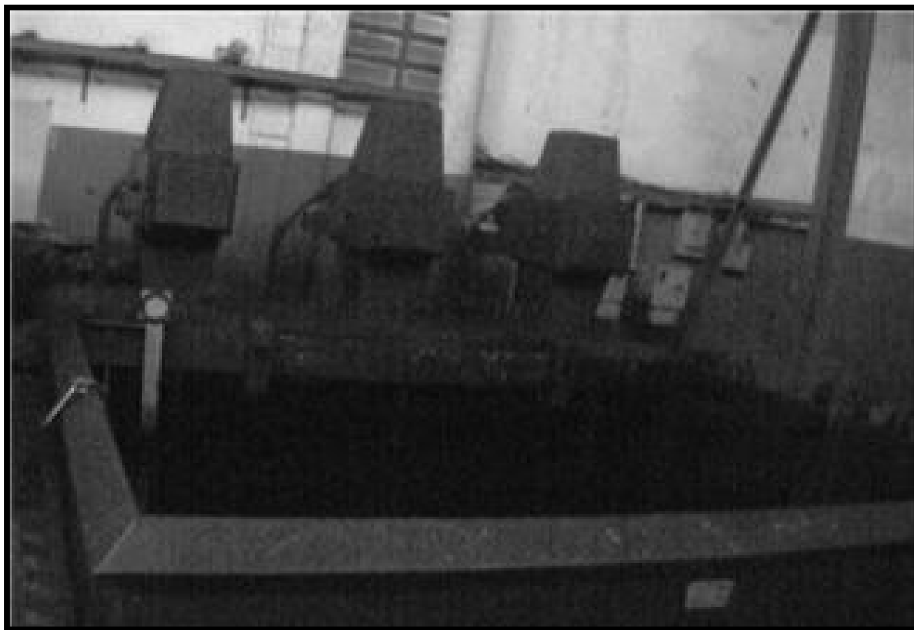
Imagen 263: del horno que se encontraba al final de la nave del área de producción. (Fuente: foto tomada por Víctor Vargas González).
