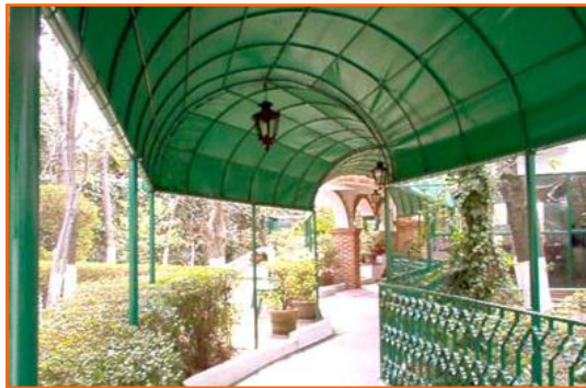
Vista del corredor de acceso.
