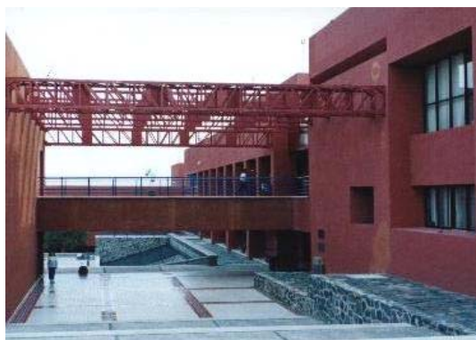
Vista desde el acceso hacia el patio interior.
