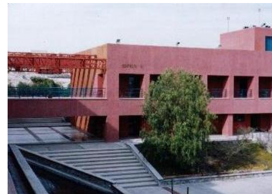
Vista parcial de la fachada y patio interiores.
